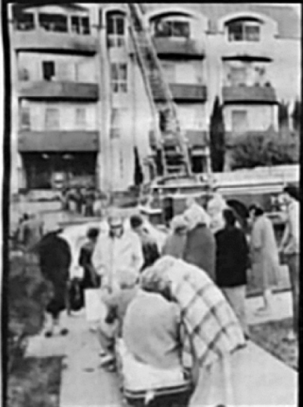
Im vierten Geschöß dieses Hauses starb Jack Cassidy. Die Feuerwehr kam zu spät
